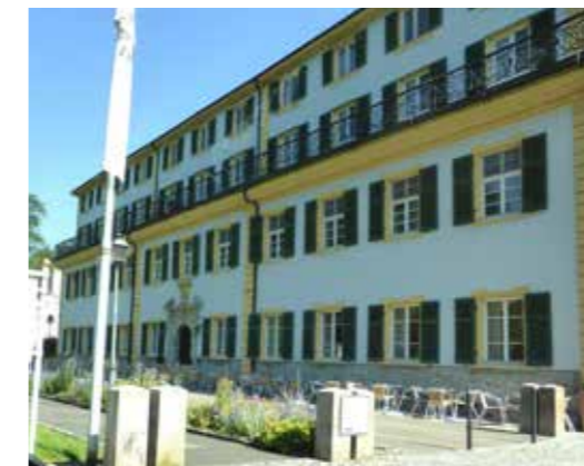
Fürstenbau in Bad Imnau
